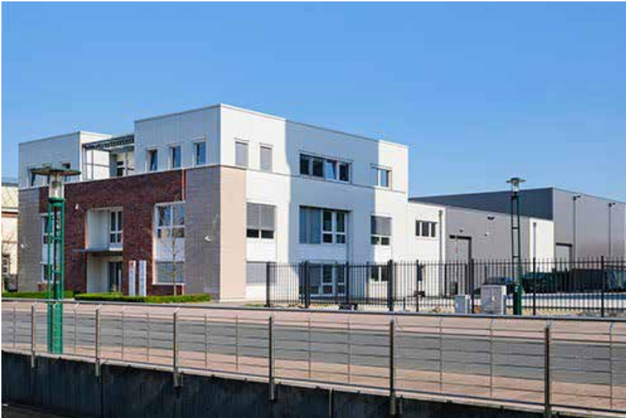
Firmensitz im Stahlwerk Becker in Willich
