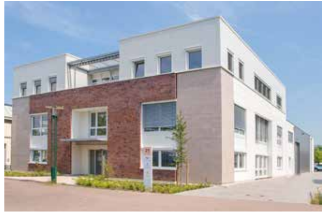
Firmensitz im Stahlwerk Becker in Willich
