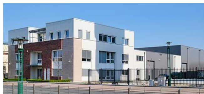
2021: N&H Firmengebäude in Willich mit neuer Lagererweiterung
