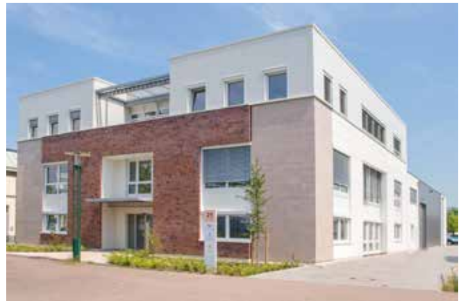
Firmensitz im Stahlwerk Becker in Willich
